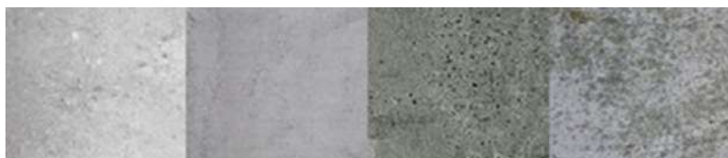
Рис. 5. Фото конструкций без трещин
