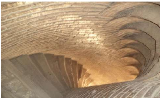
Рис. 2. Фрагмент внутренней части стен и лестницы минарета Калян, выполненных из жженого кирпича
