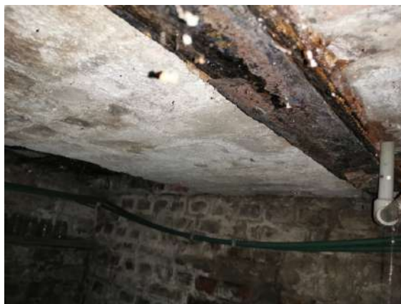
Рис. 2. Расслаивающая коррозия металла
