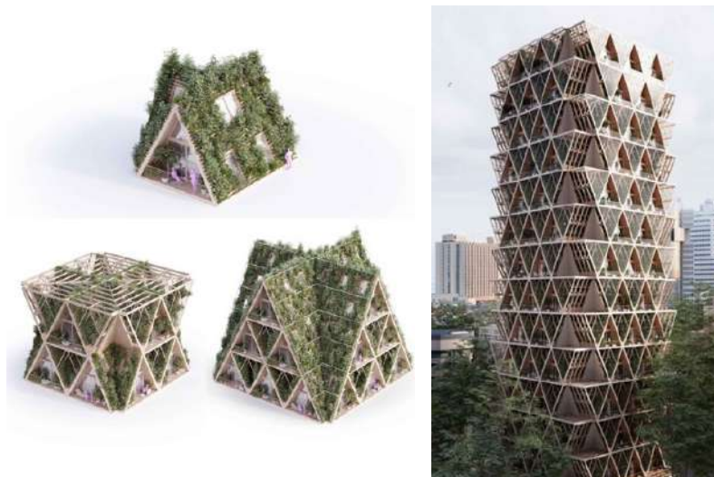
Рис. 2. Модульные жилые дома из CLT-панелей “Farm House”, арх. Studio Precht
