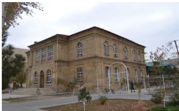
Рис. 4. Общий вид здания «Дом ученых» (с северо-запада)
