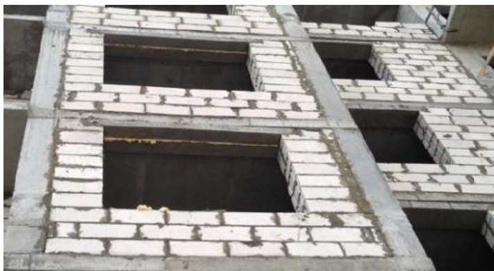
Рис. 2. Использование ячеистого бетона
