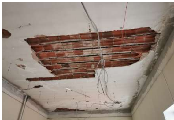
Рис. 4. Разрушение керамблоков
