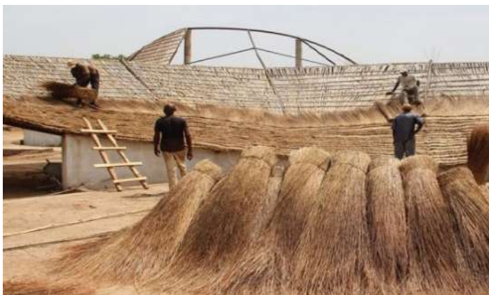
Рис. 4. Реализация крыши на основе растений, тростника и бамбука
